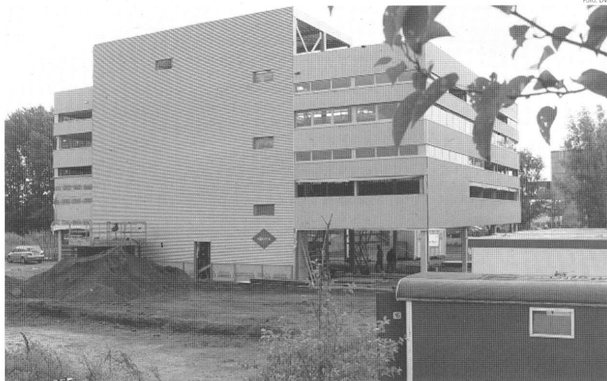
Het nieuwe, innovatieve gebouw van de Verkeerspolitie in aanbouw in Amsterdam Zuidoost
