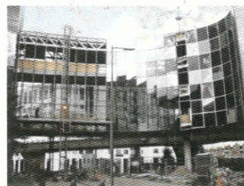
Loopbrug hangt aan minimale vakwerklijger
